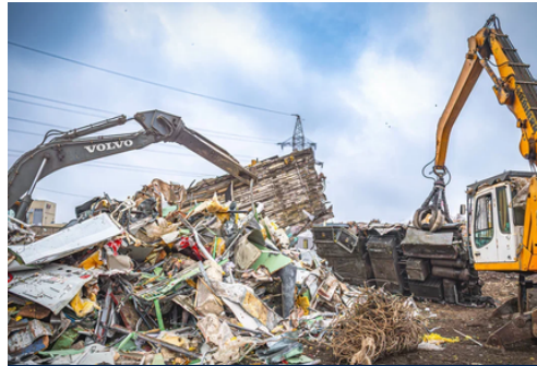
ДЕМОНТАЖ ЗДАНИЙ И МЕТАЛЛОКОНСТРУКЦИЙ
