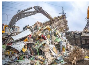
ДЕМОНТАЖ ЗДАНИЙ И МЕТАЛЛОКОНСТРУКЦИЙ
